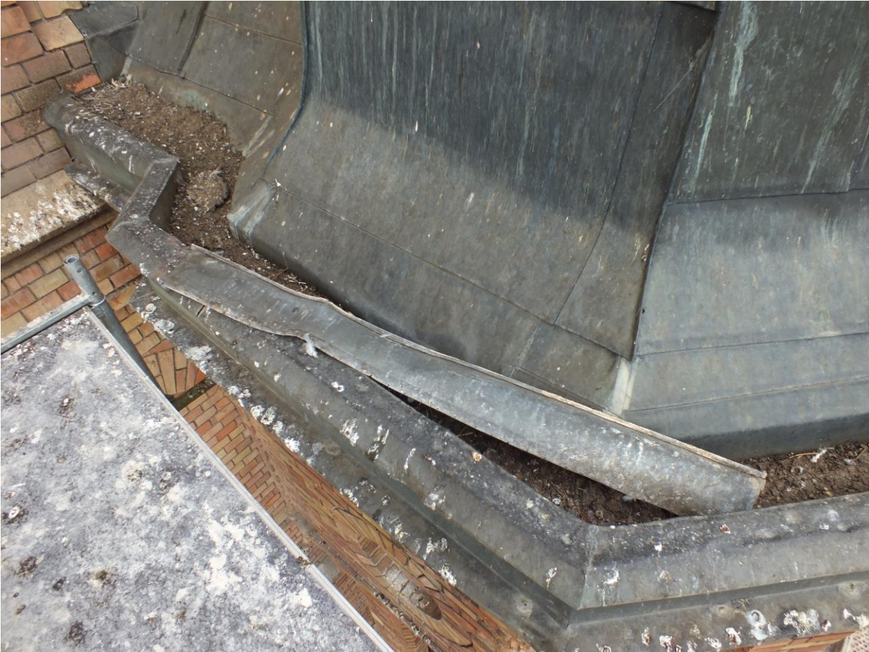
EGYH-KCP-18-P-0067 Bátaszéki Templom: Tetőfelújítás
