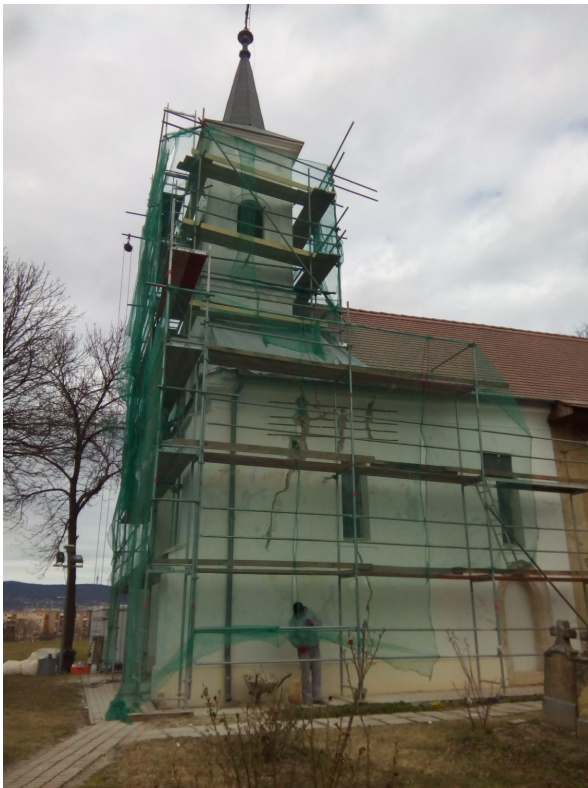
EGYH-KCP-18-P-0067 Málomi Templom felújítás
